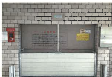
立体的駐車場入口部分
