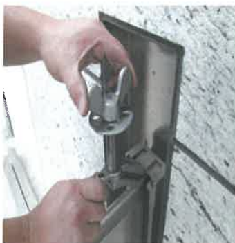
止水レールの上部に上部ボルトを差し込み、上から締め付けます。
