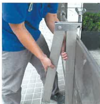
バックサポートを床の補強柱差し込み口に差し込みます。
