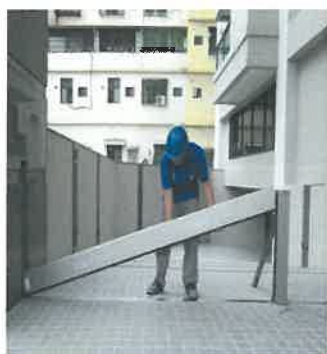
止水レールに止水パネルを上から入れます。
