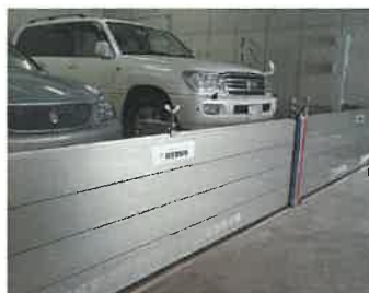
機械式駐車場開口部
