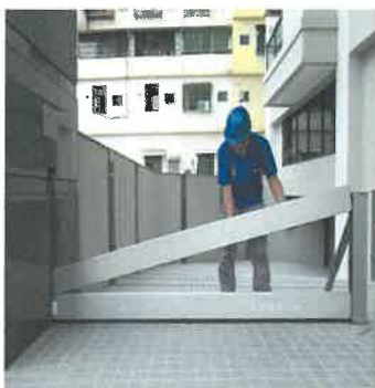
止水レールに止水パネルを上から入れます。
