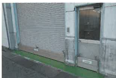
工場出入口部分
