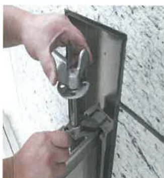
止水レールの上部に上部ボルトを差し込み、上から締め付けます。
