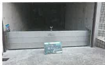
半地下駐車場入口部分
