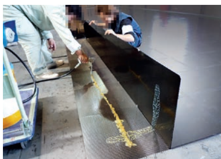
防水・防塵用グリスの注入
