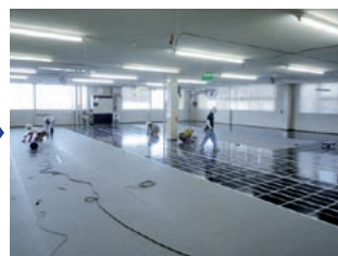
保護シートの敷設
